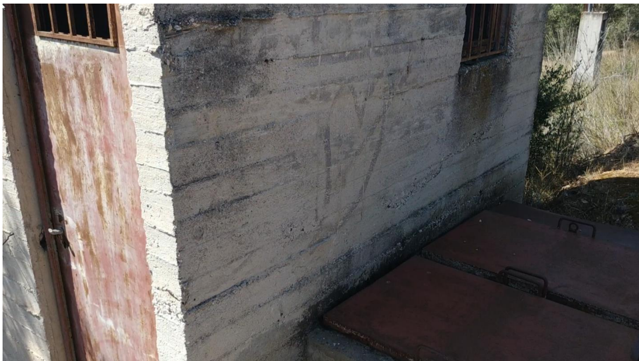
Εικόνα 10: Η δεξαμενή «Φίλη» - R1
