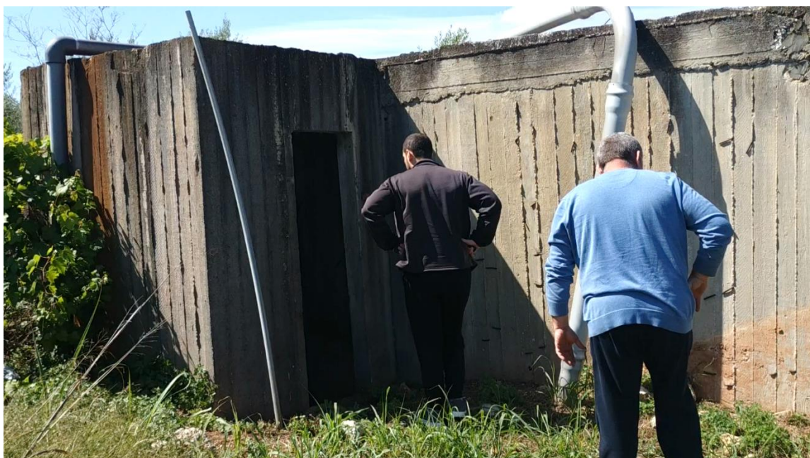
Εικόνα 11: Η δεξαμενή «Σοφοκλή»
